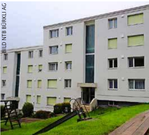
Sanierte Fassade mit Lüfterauslässen.
