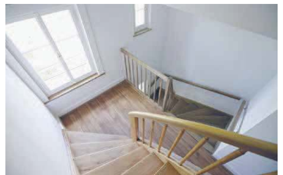
Die alten Treppen wurden aufgefrischt, nur die zum ersten Obergeschoss ist neu.
