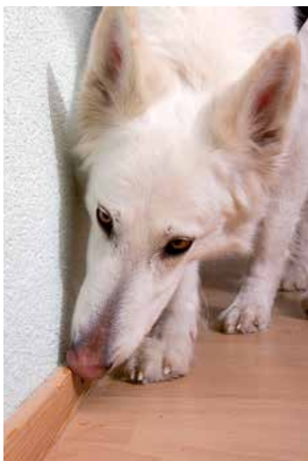
Abb. 1: Schimmelspürhund Amy bei der Arbeit
